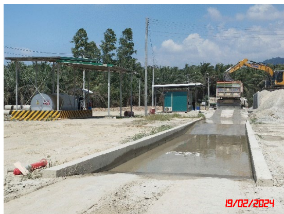
รูปที่ 9 บ่อล้างล้อรถบรรทุกแร่
